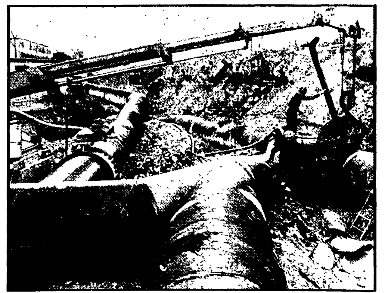
La posa delle condutture all'Anconella
