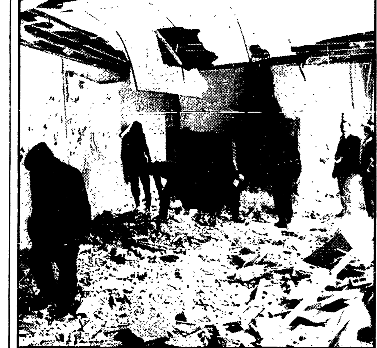
THIENE (Vicenza) - L'interno dell'abitazione completamente distrutta dall'esplosione
