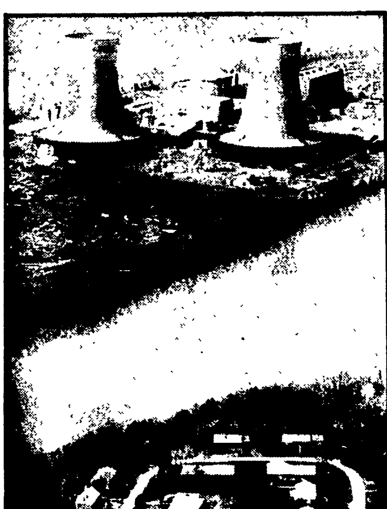
HARRISBURG — Veduta parziale della centrale nucleare
