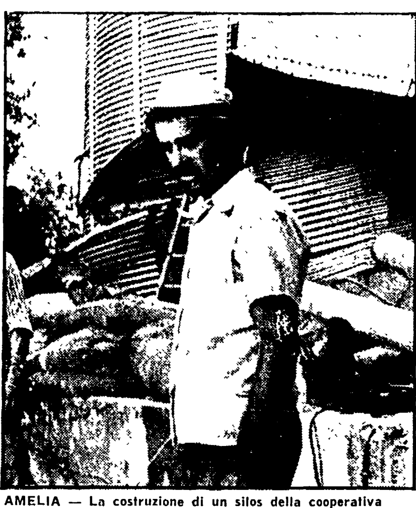
AMELIA - La costruzione di un silos della cooperativa
