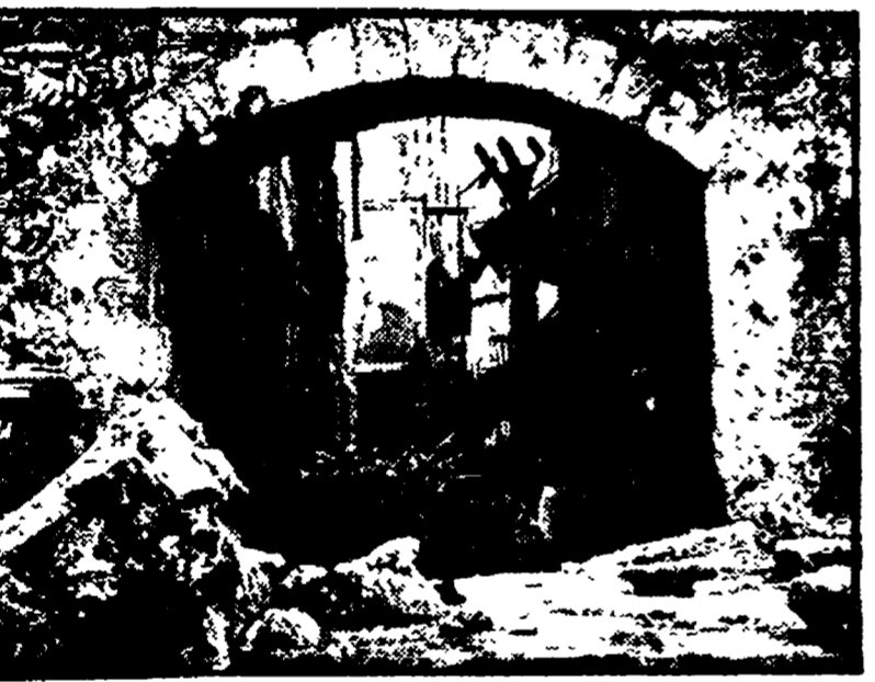
Montenegro: dopo il terremoto
