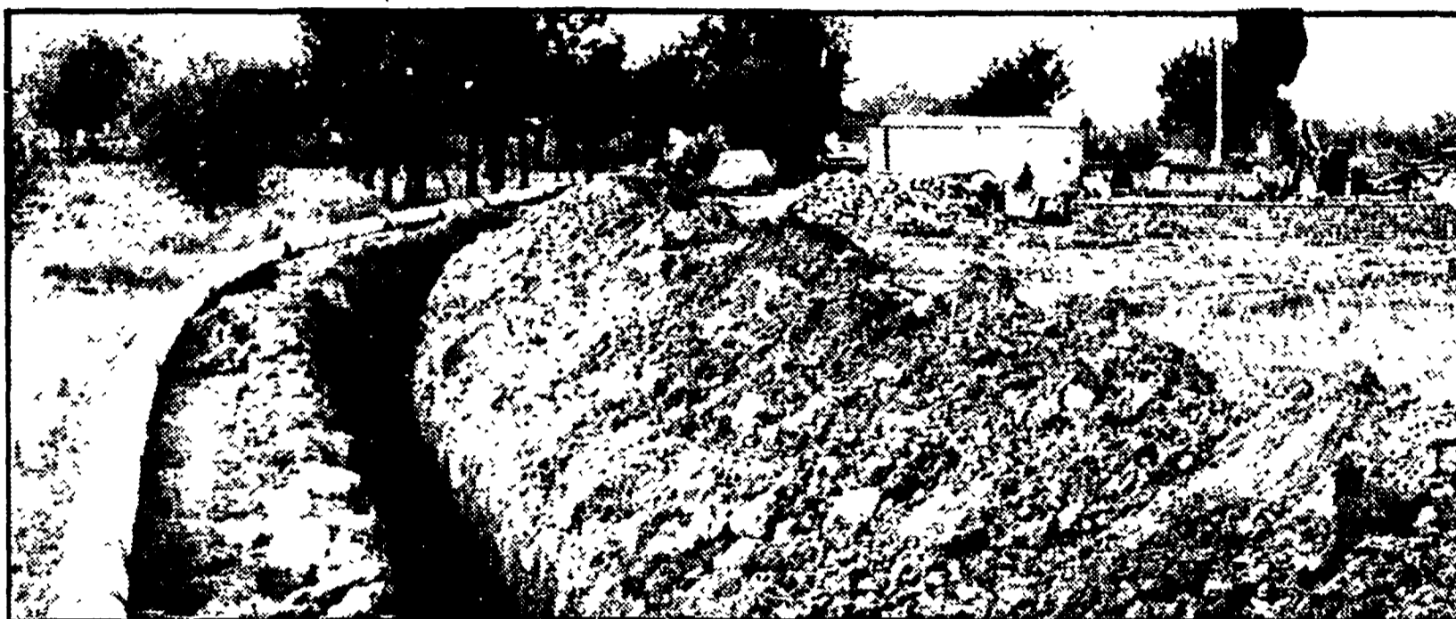
Un tratto dei lavori in corso per l'allacciamento del gas metano a Settignano
