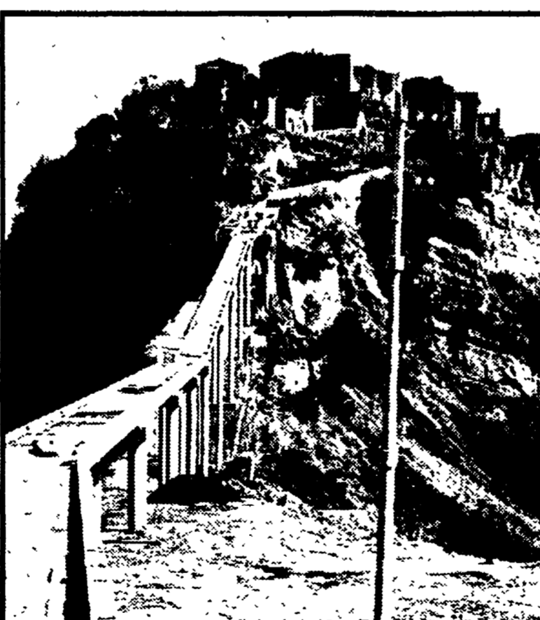
Il ponte dissestato di Civita Bagnoregio
