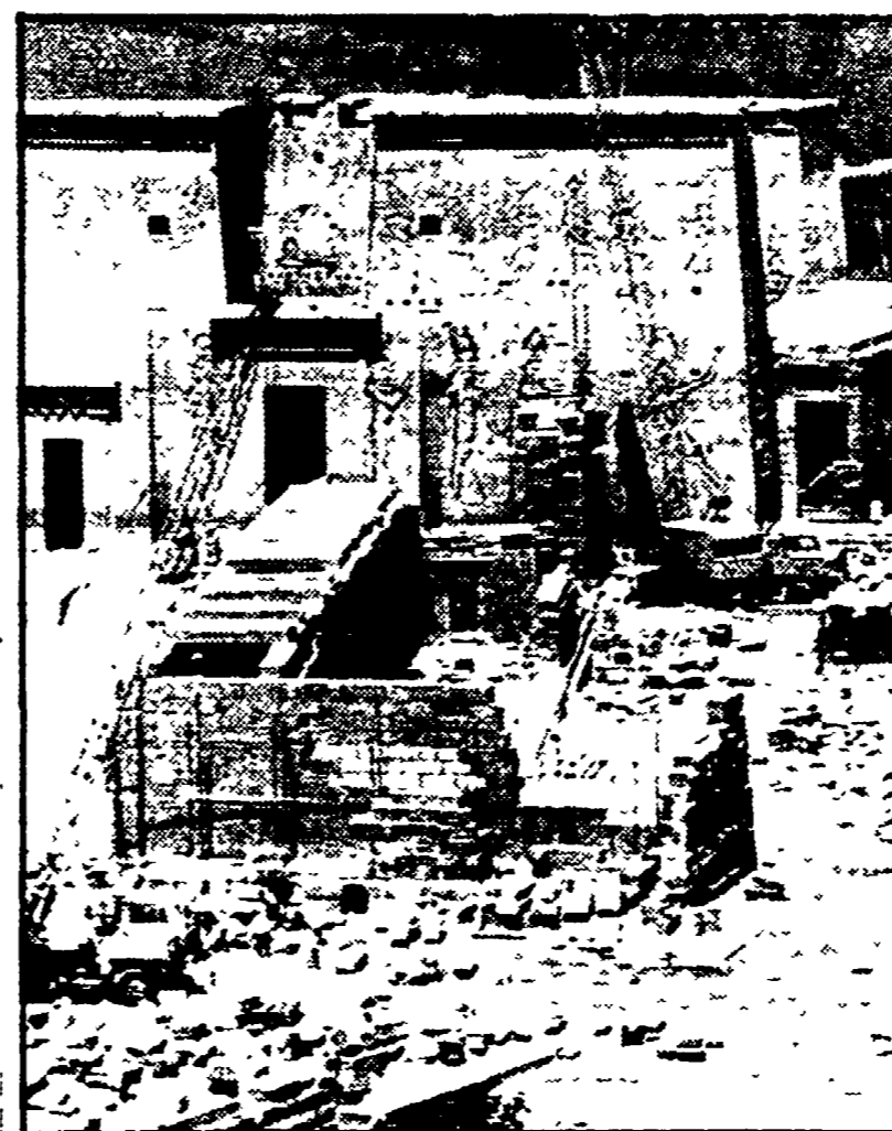
I monumenti di File ricostruiti sull'isola di Agilkia. In alto, il cantiere di stoccaggio dei blocchi del tempio
