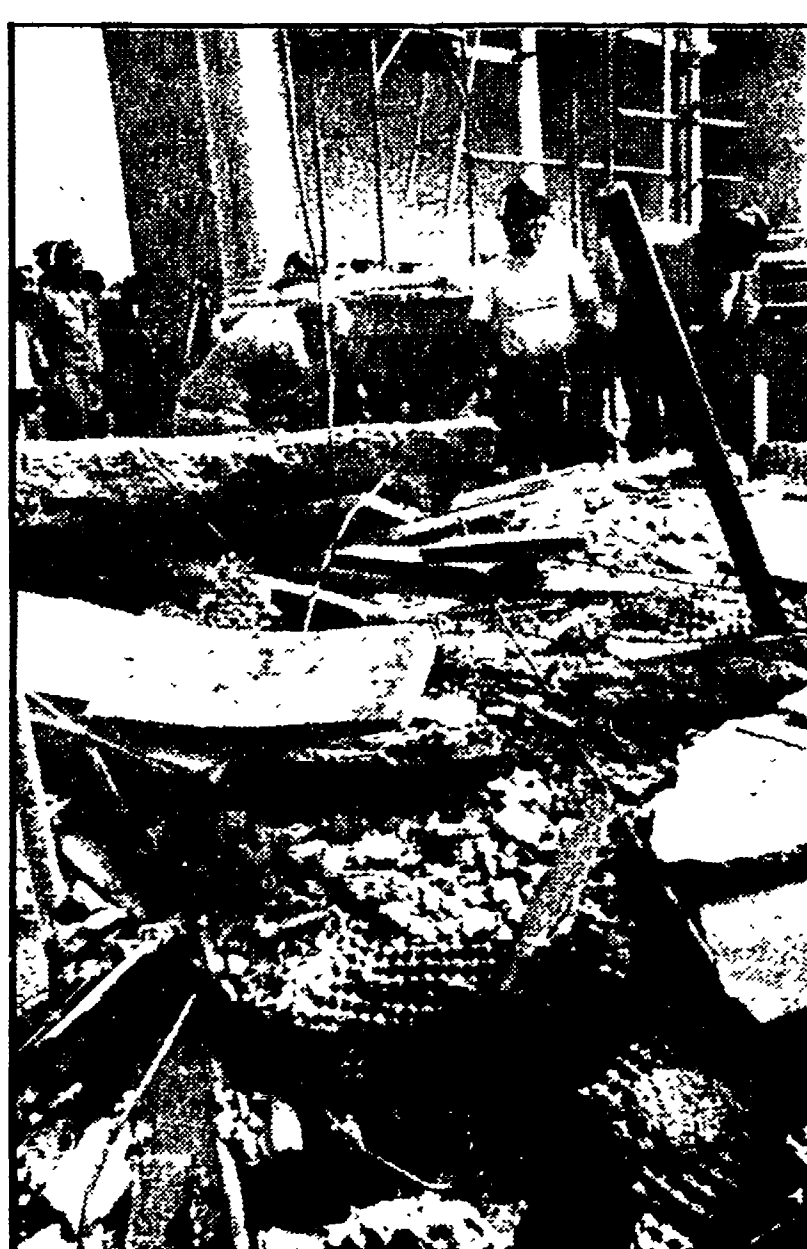
PALERMO — Vigili del fuoco tra le macerie della Biblioteca nazionale crollata
