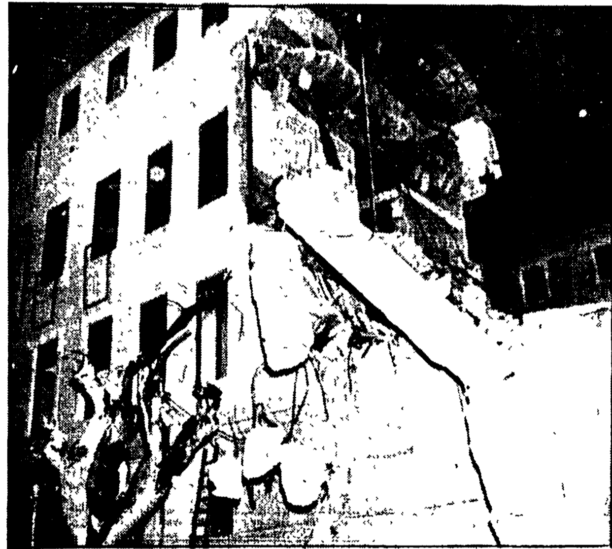
PARMA — Due drammatiche immagini dello spaventoso crollo che ha completamente distrutto un'ala dell'ospedale
