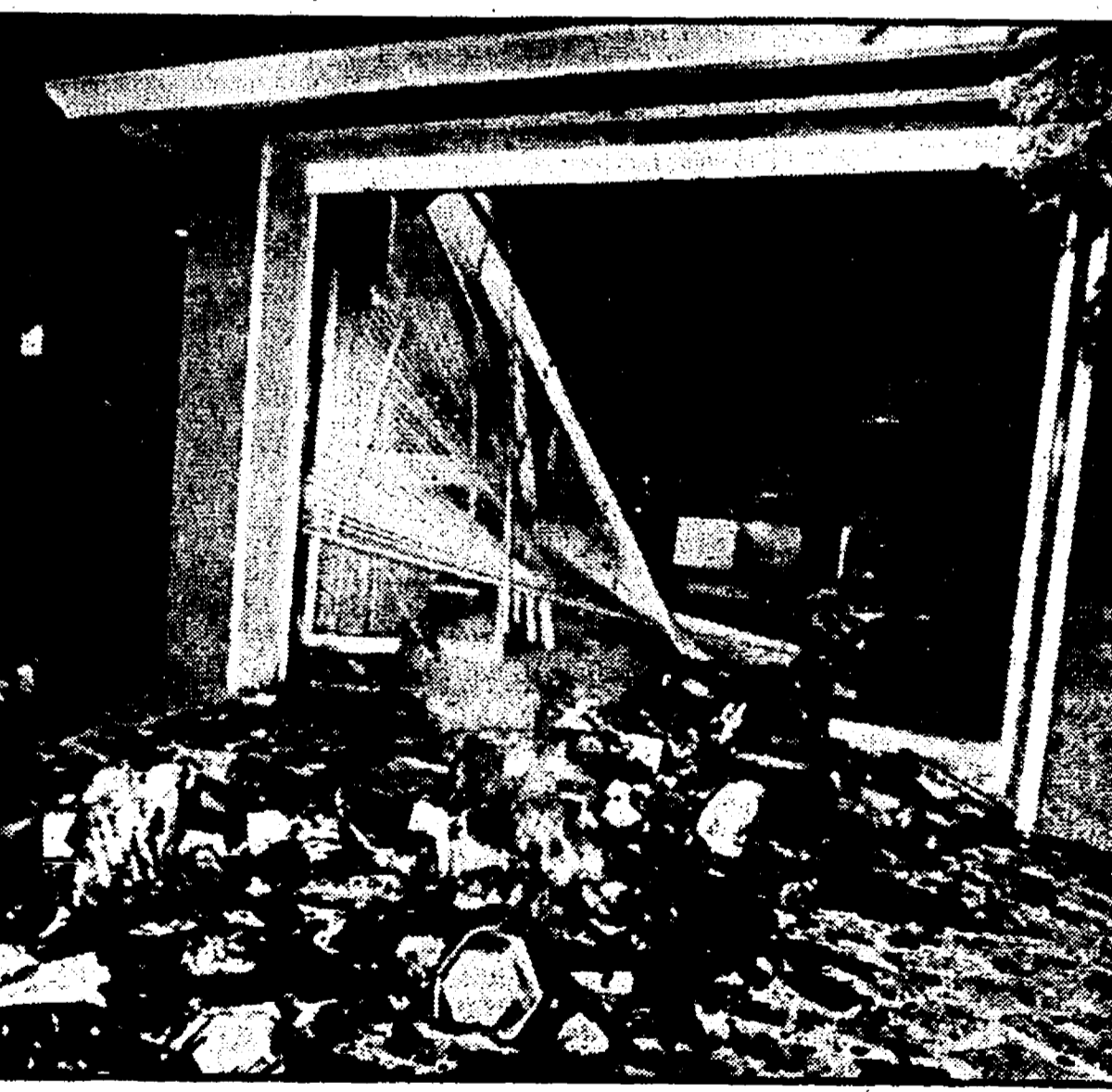
PADOVA — L'agenzia immobiliare di via Getzta distrutta dalle fiamme
