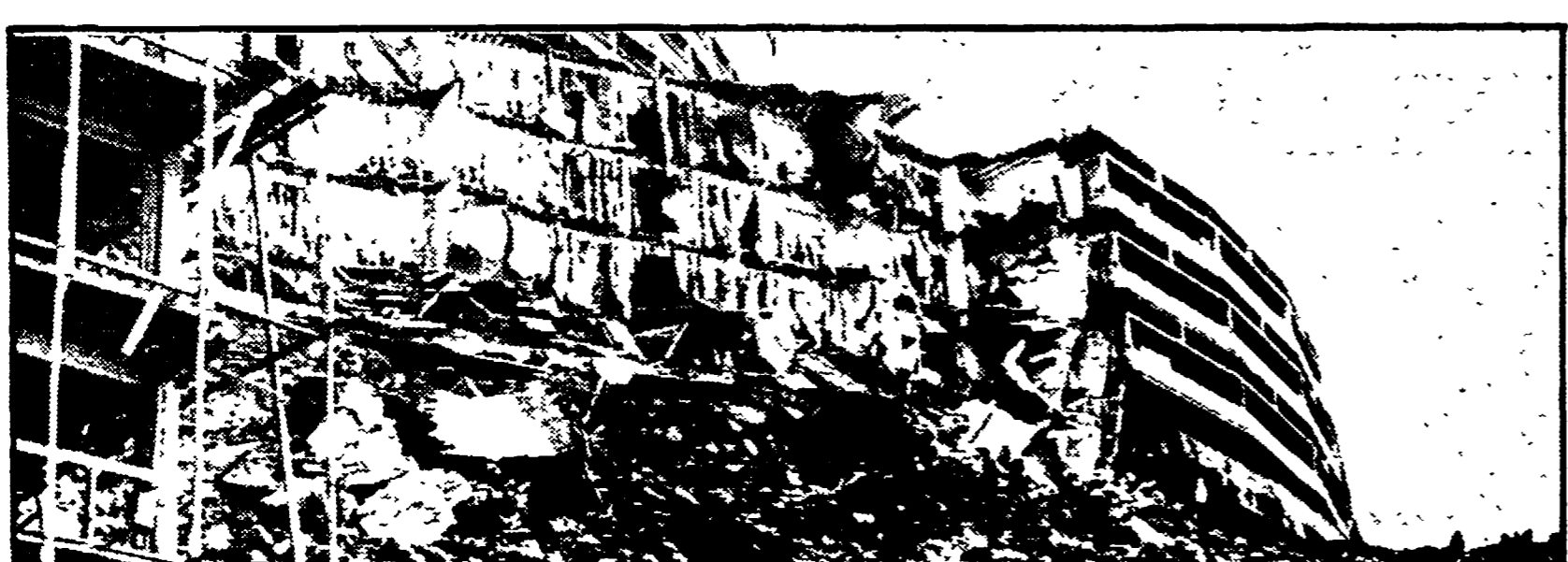
Un'ala di un palazzo franato in seguito ad una alluvione
