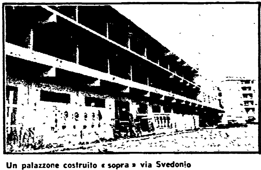
Un palazzo costruito « sopra » via Svedonia
