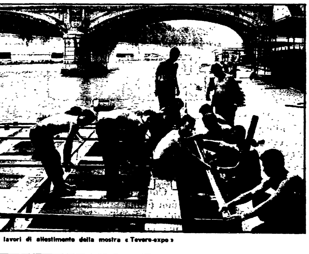
I lavori di allestimento della mostra «Tevere-expo»
