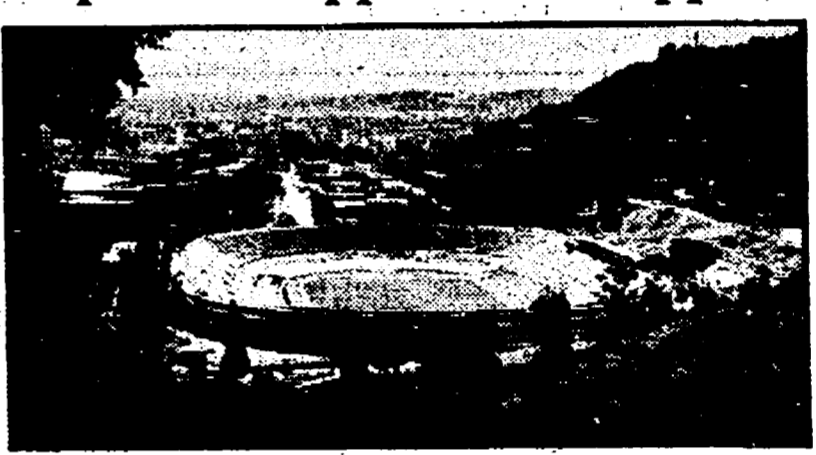
ROMA - Dopo una serie di critiche piovute dalla stampa il CONI ha pensato di fare il punto sulla situazione del due maggiori impianti sportivi romani, gli stadi Olimpico e Flaminio. I lavori complessivi a cui i due impianti saranno sottoposti verranno finanziati in parte dal CONI e per il rimanente dalla società che ha comprato il terreno.
