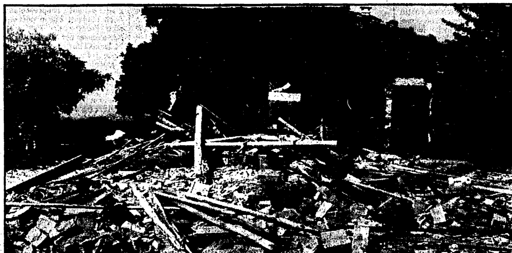
Le macerie della casa di Giulio Santarelli, nei pressi di Marino
