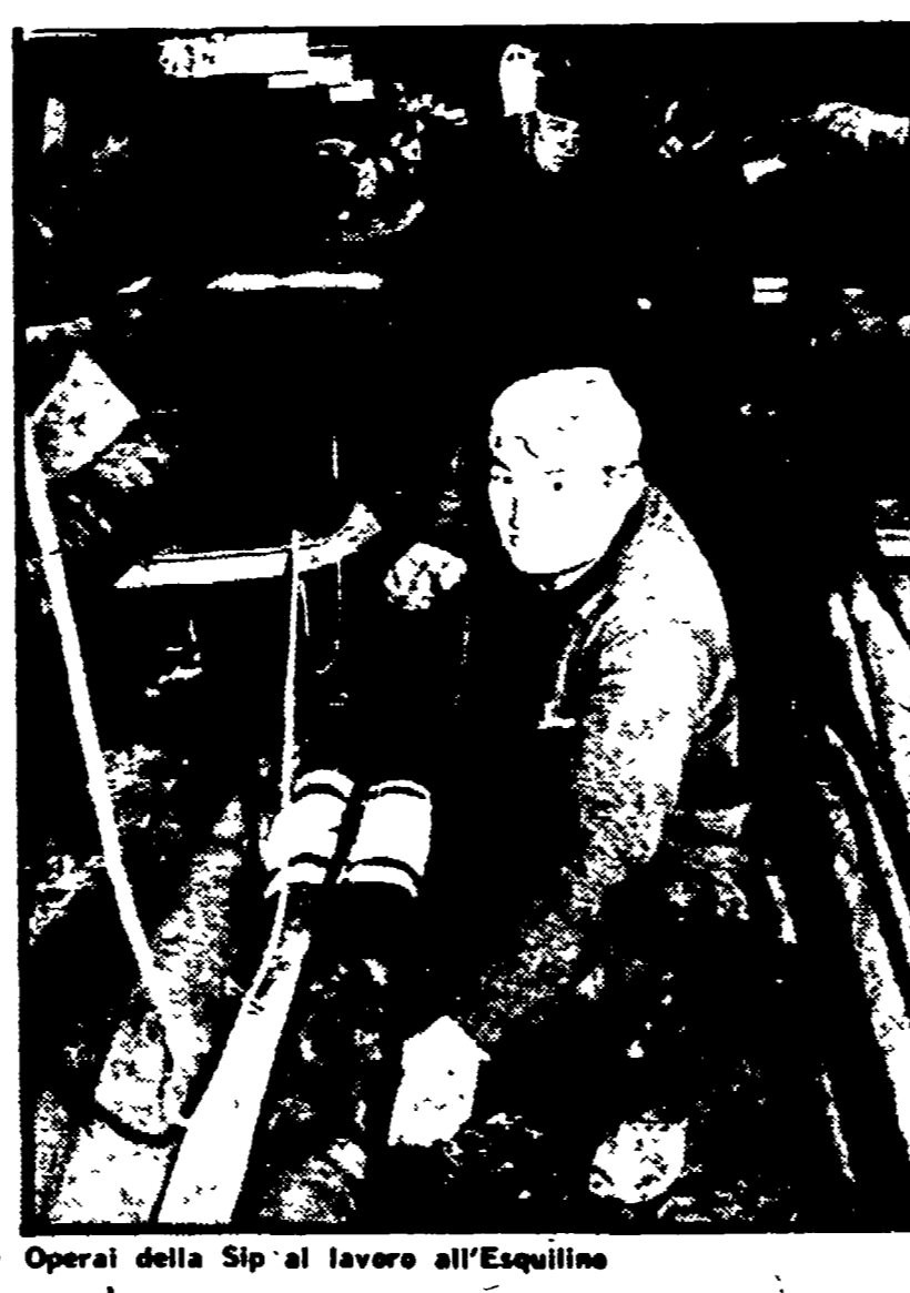
Operai della Sip al lavoro all'Esquilino
