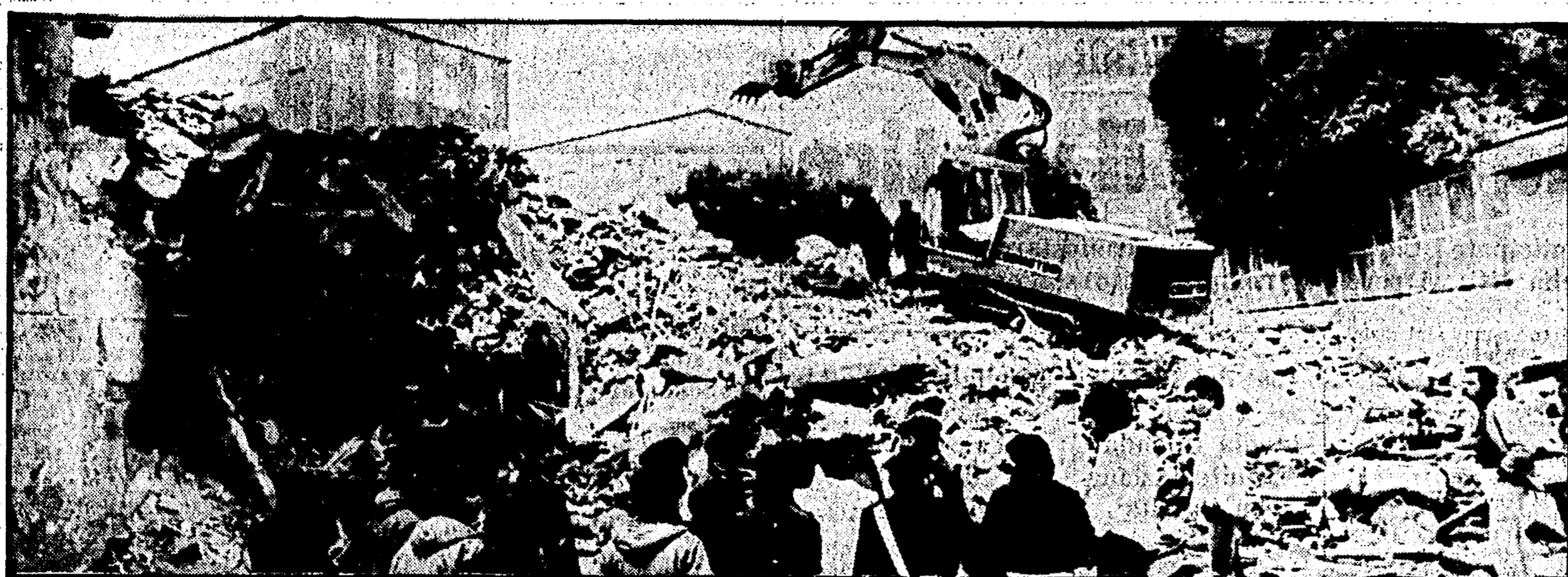
NAPOLI — Vengono rimosse le macerie del palazzo di nove piani dove hanno perso la vita alcune decine di persone
