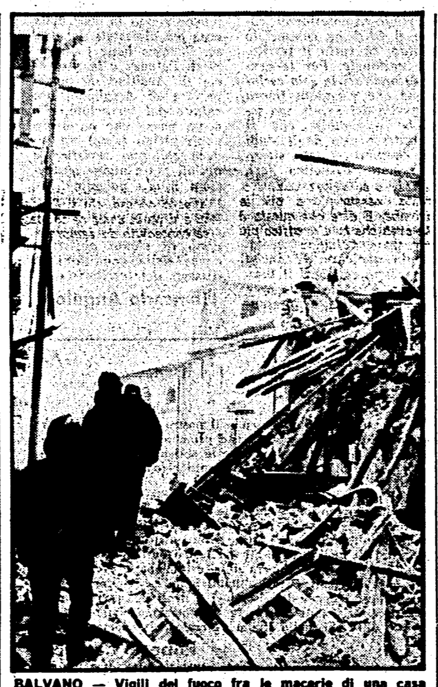
BALVANO - Vigili del fuoco fra le macerie di una casa crollata; in fondo il campanile della chiesa di Santa Maria Assunta che al momento del terremoto era piena di fedeli
