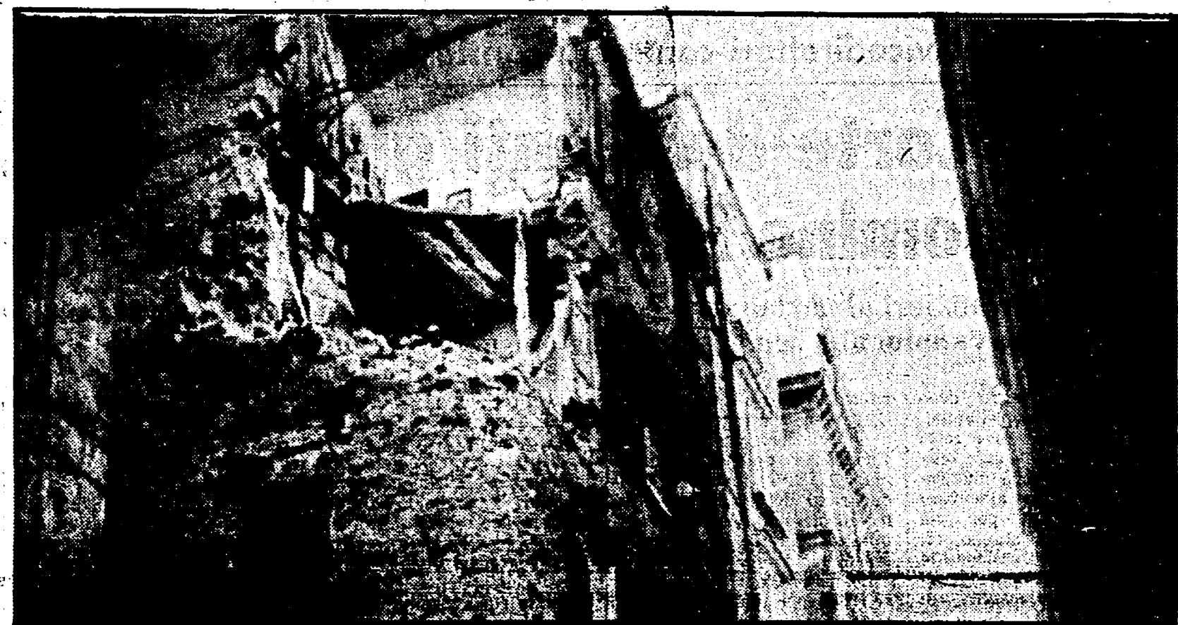
NAPOLI — Il terremoto continua a colpire: ieri a Napoli è crollato un altro palazzo del centro storico. Non si lamenta nessuna vittima. L'edificio era stato dichiarato inagibile, ma alcuni inquilini avevano continuato ad abitarci
