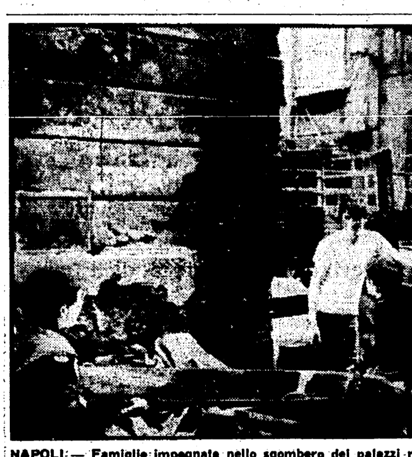
NAPOLI - Famiglie impegnate nello sgombero dei palazzi resi pericolanti dalle scosse del terremoto.
