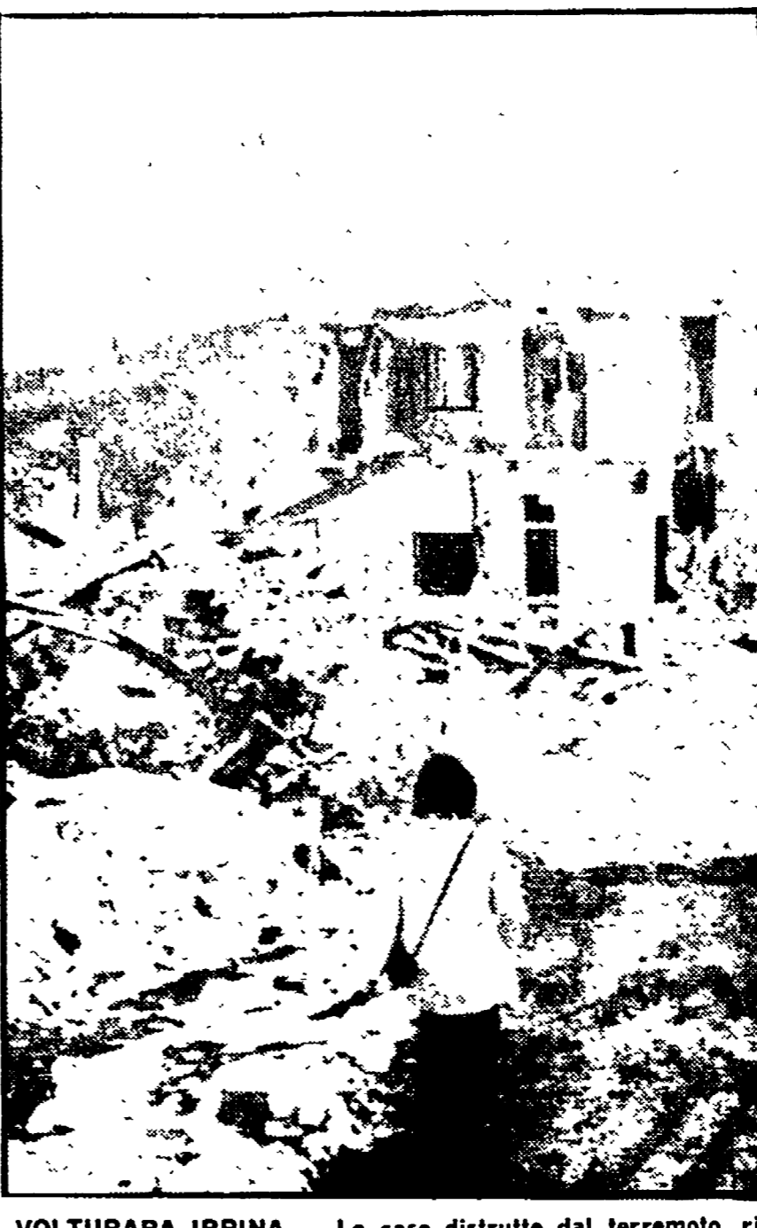
VOLTURARA IRPINA — Le case distrutte dal terremoto, ricoperte di neve dopo il maltempo che ha imperversato nella zona negli ultimi giorni
