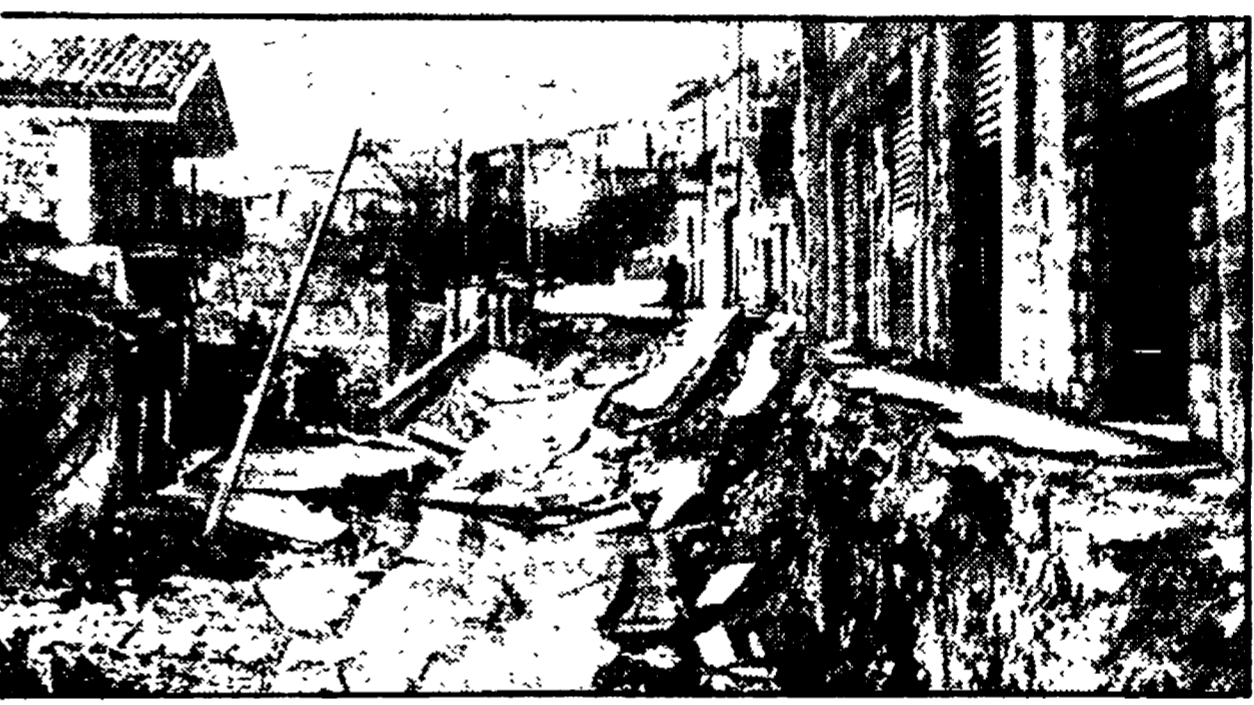
Una strada di Calitri completamente franata
