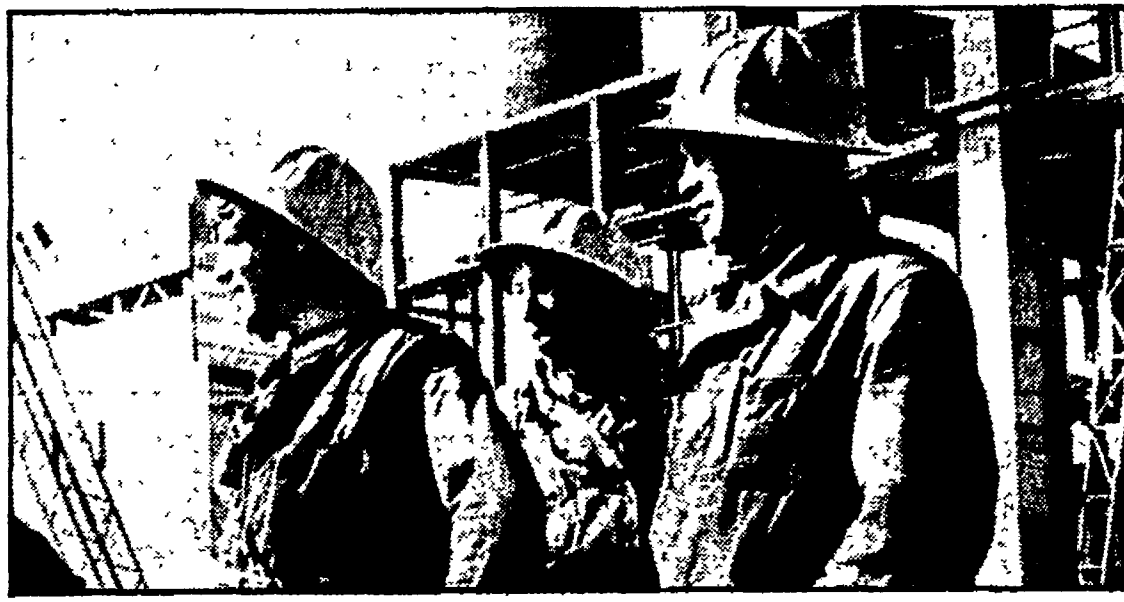
Operai edili in un cantiere. Nella foto sotto una fabbrica metalmeccanica
