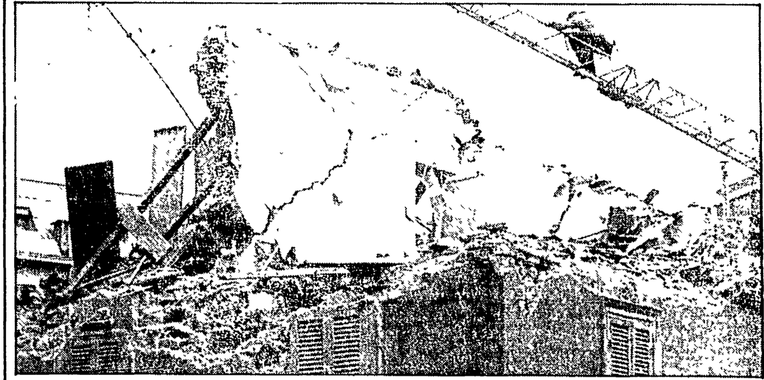
La palazzina di via Antonio Pignatelli dopo l'esplosione nell'attico
