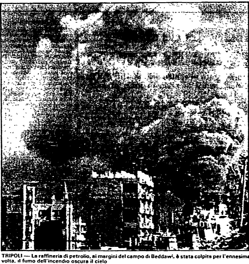
TRIPOLI — La raffineria di petrolio, ai margini del campo di Beddawi, è stata colpita per l'ennesima volta, il fumo dell'incendio oscura il cielo
