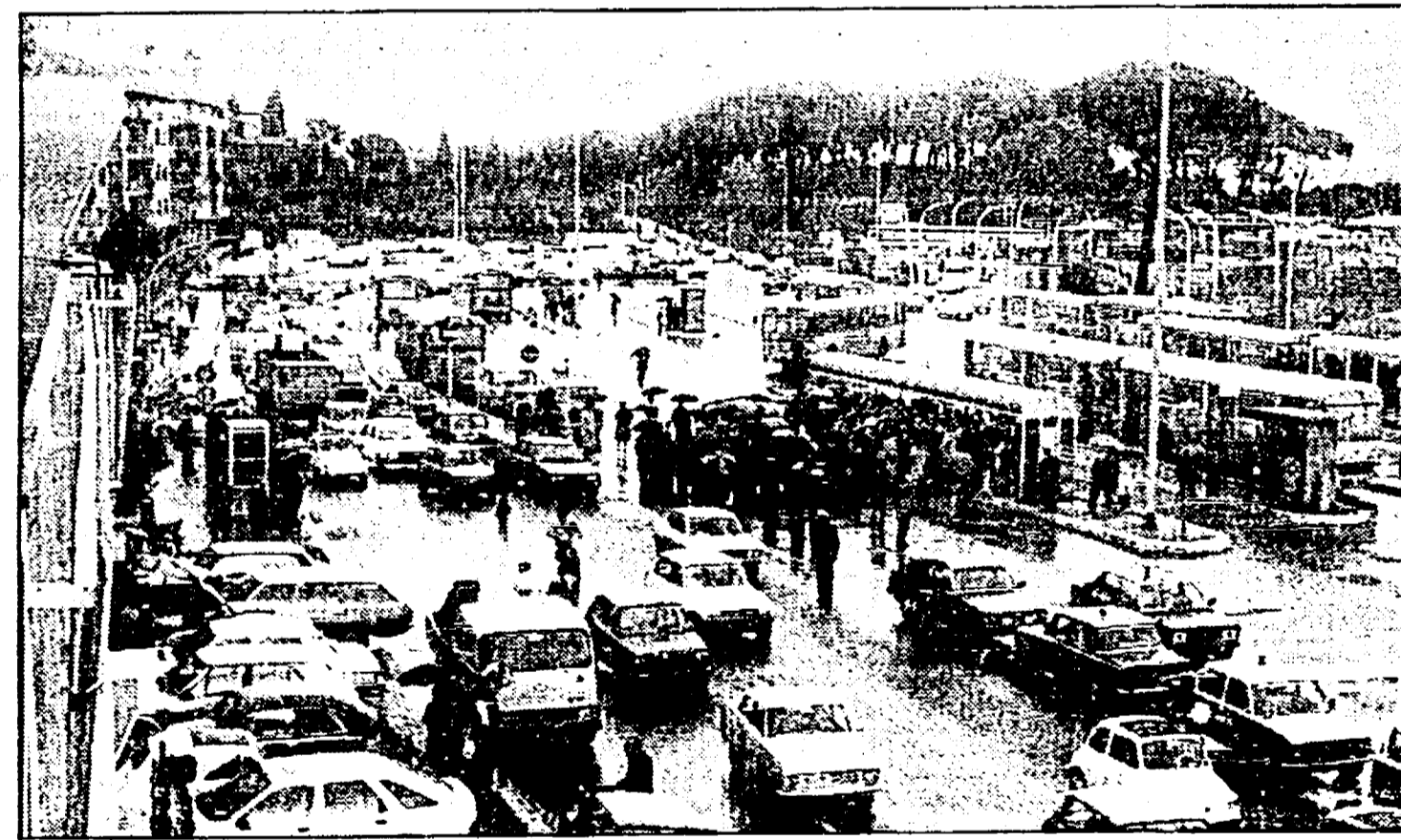
Il nuovo modernissimo terminal dell'ATAC a piazza dei Giuriconsulti, a Boccea
