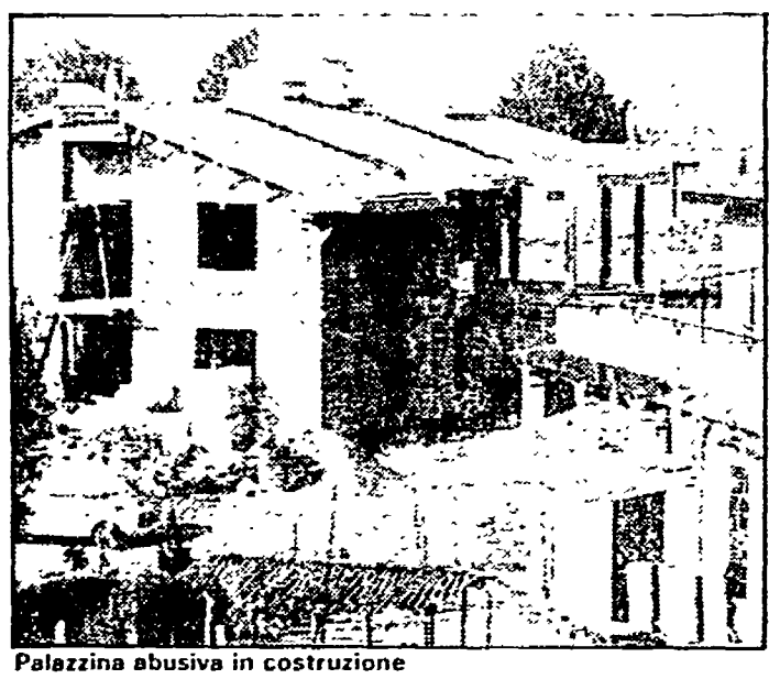
Palazzina abusiva in costruzione
