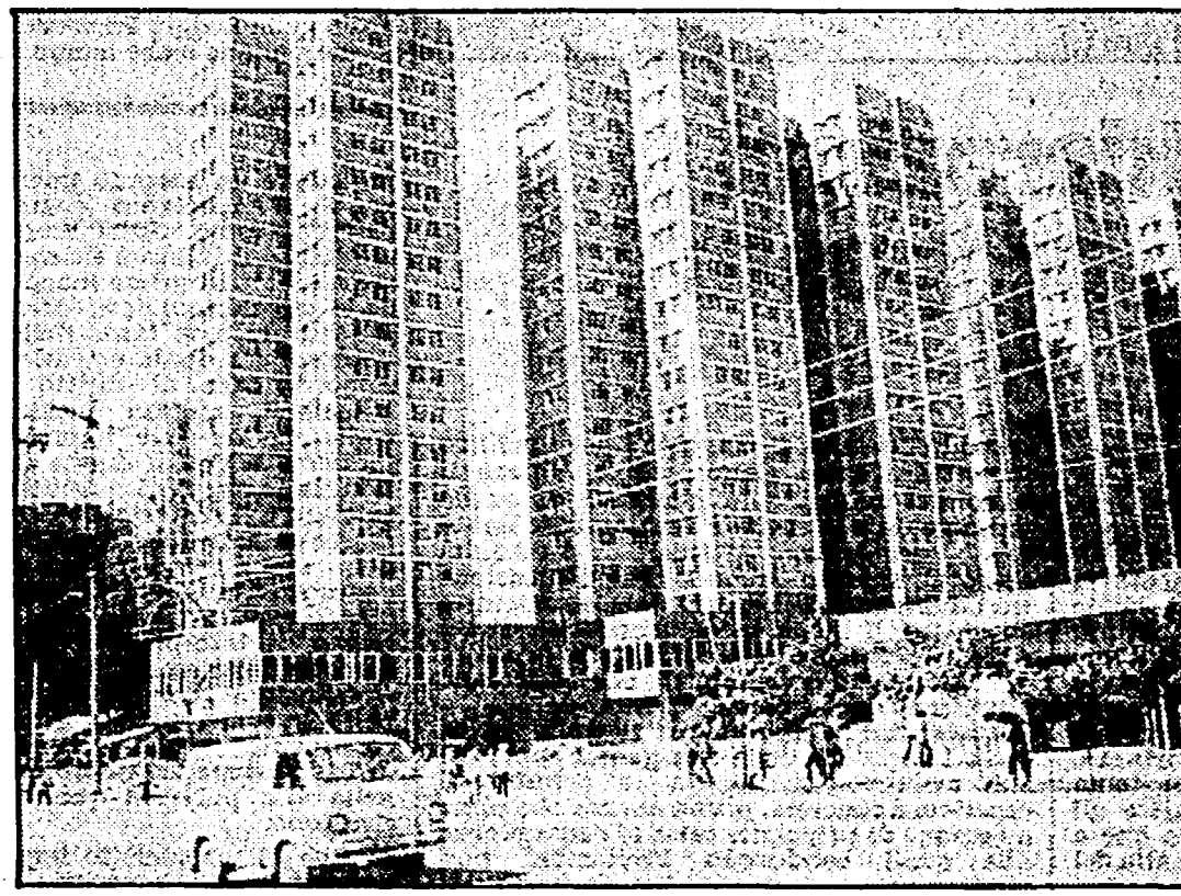
Grattacieli per uffici a Shenzhen. Nella cartina: Hong Kong, la zona economica speciale Shenzhen e, nella terza cerchia, la zona di Shenzhen; poi c'è la Cina
