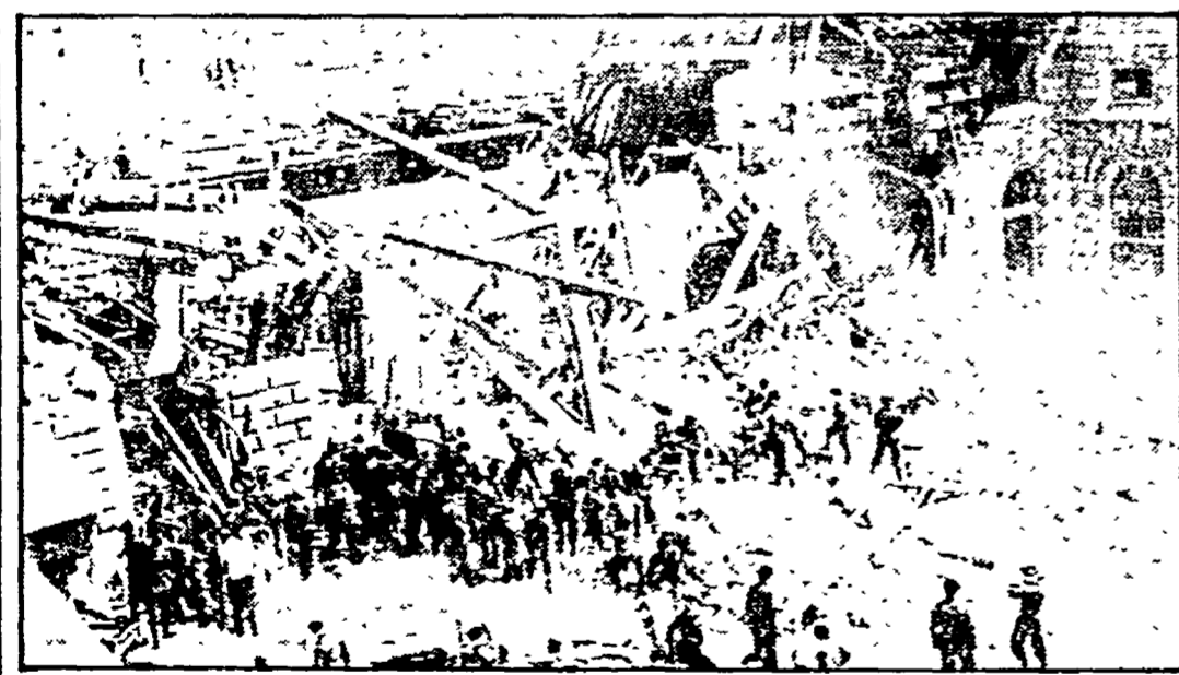
BOLOGNA — Una tragica immagine della stazione di Bologna subito dopo lo scoppio della bomba che ha provocato la strage
