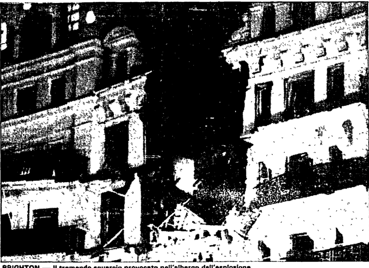
BRIGHTON — Il tremendo squarcio provocato nell'albergo dall'esplosione
