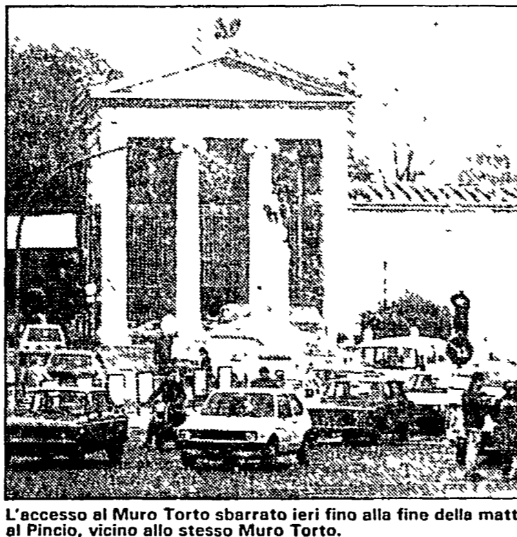
L'accesso al Muro Torto sbarrato ieri fino alla fine della mattinata. In alto: la voragine che si è aperta lungo la salita che porta al Pincio, vicino allo stesso Muro Torto.
