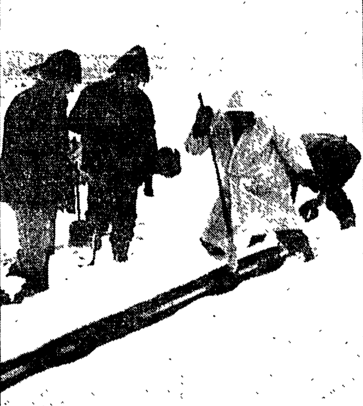
MILANO - Alcuni addetti tentano di rendere agibili gli scambi alla stazione Centrale
