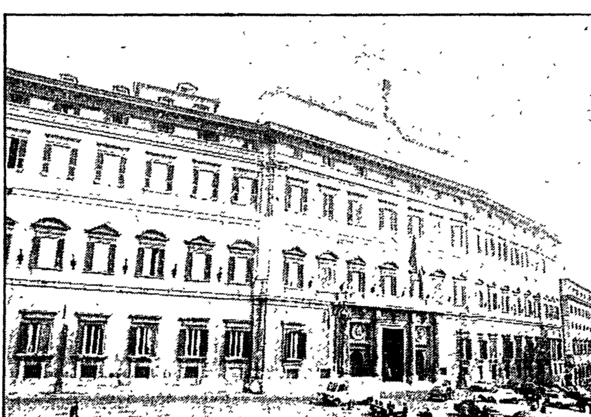
ROMA - Palazzo Montecitorio, sede della Camera dei deputati
