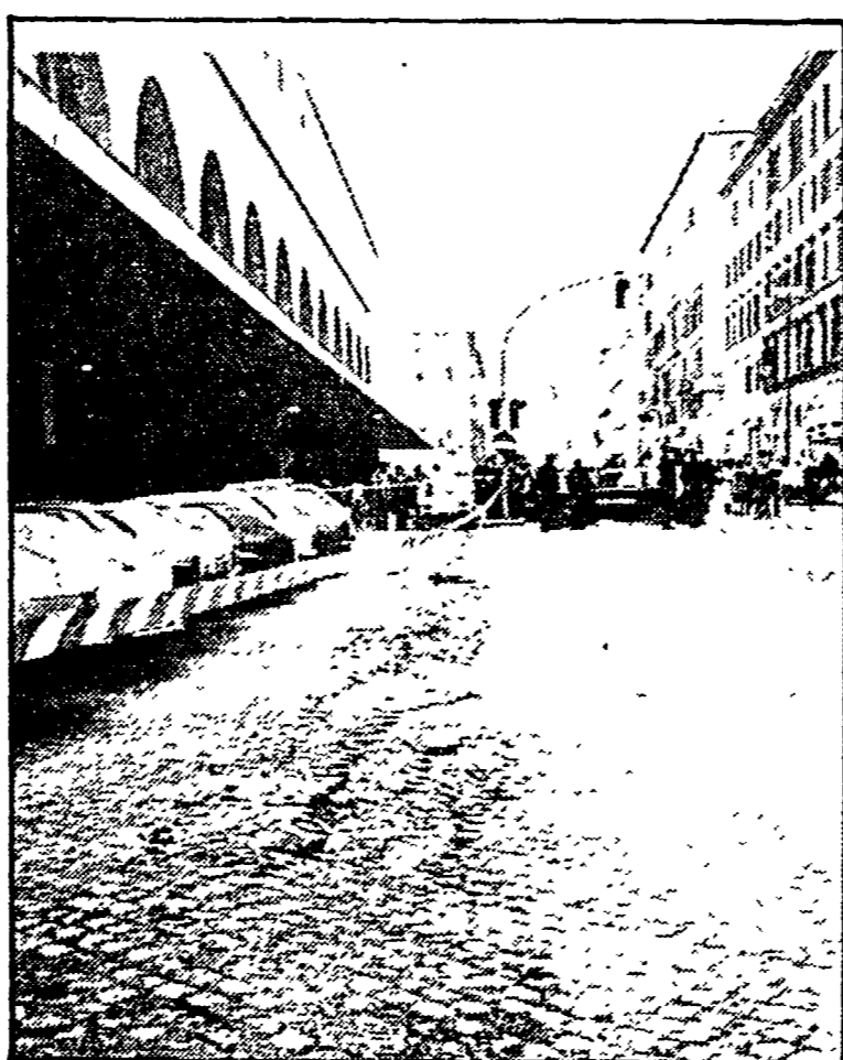
Via Marsala transennata dopo l'esplosione di venerdì
