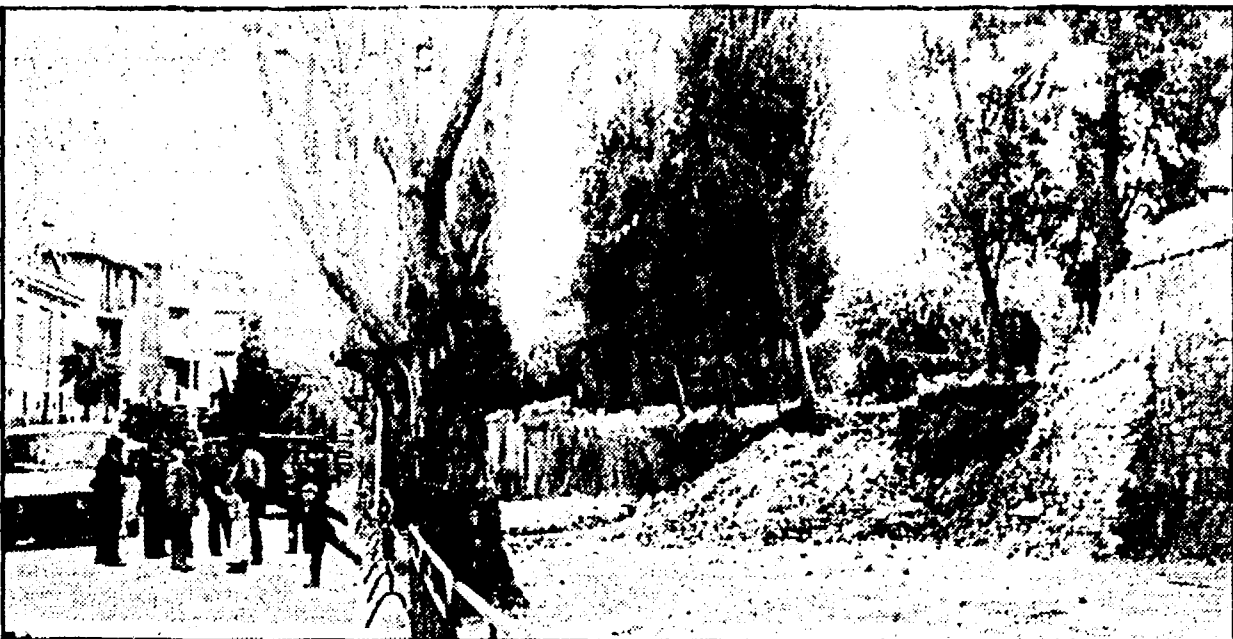
Il muro del convento di via Vitellia crollato improvvisamente ieri mattina. C'è stato panico, quattro auto sono rimaste danneggiate, ma per fortuna nessun ferito.
