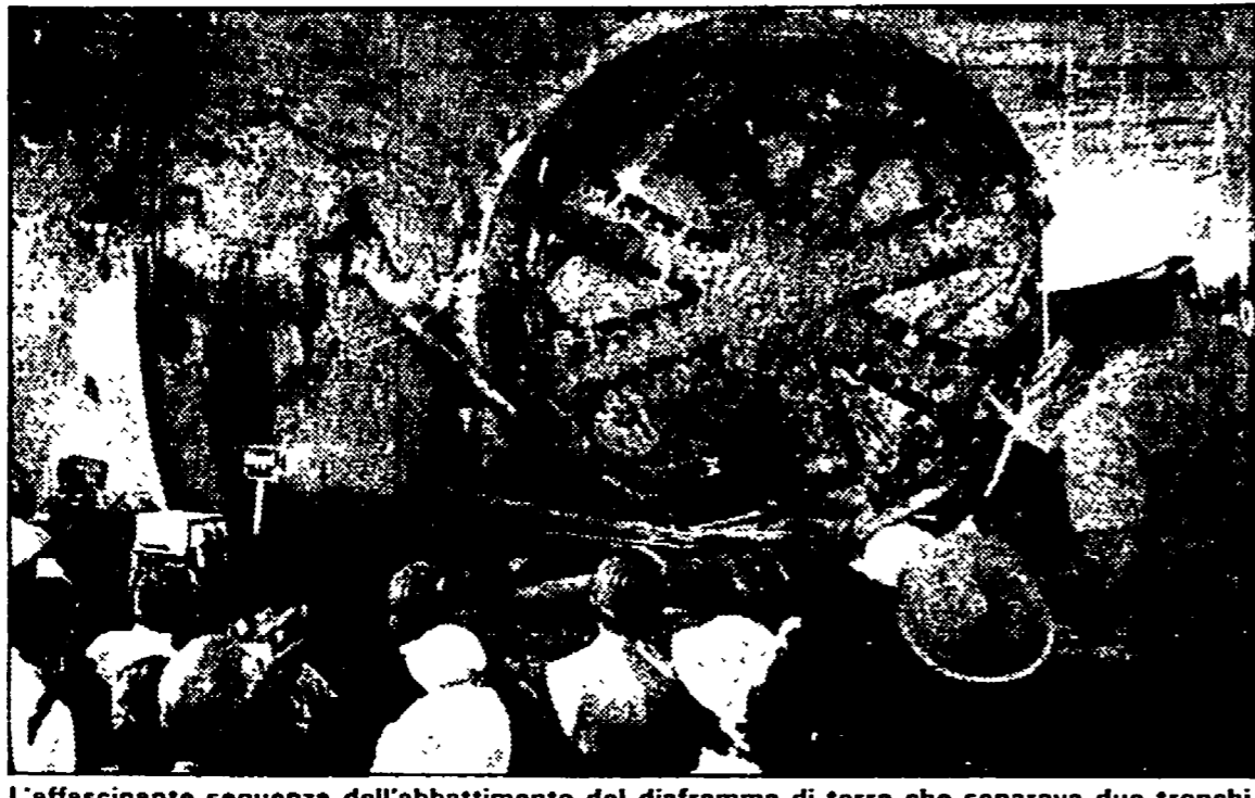
L'affascinante sequenza dell'abbattimento del diaframma di terra che separava due tronchi della galleria del metrò a Castro Pretorio. In alto, gli operai al lavoro subito dopo.
