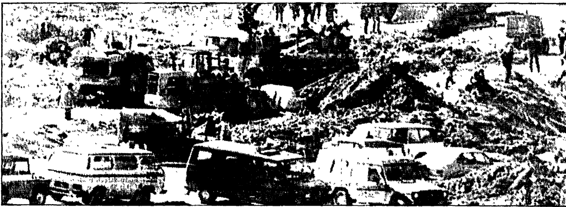
CAVALESE — Bulldozer al lavoro nel luogo dove sorgevano gli alberghi distrutti dalla valanga di fango e detriti
