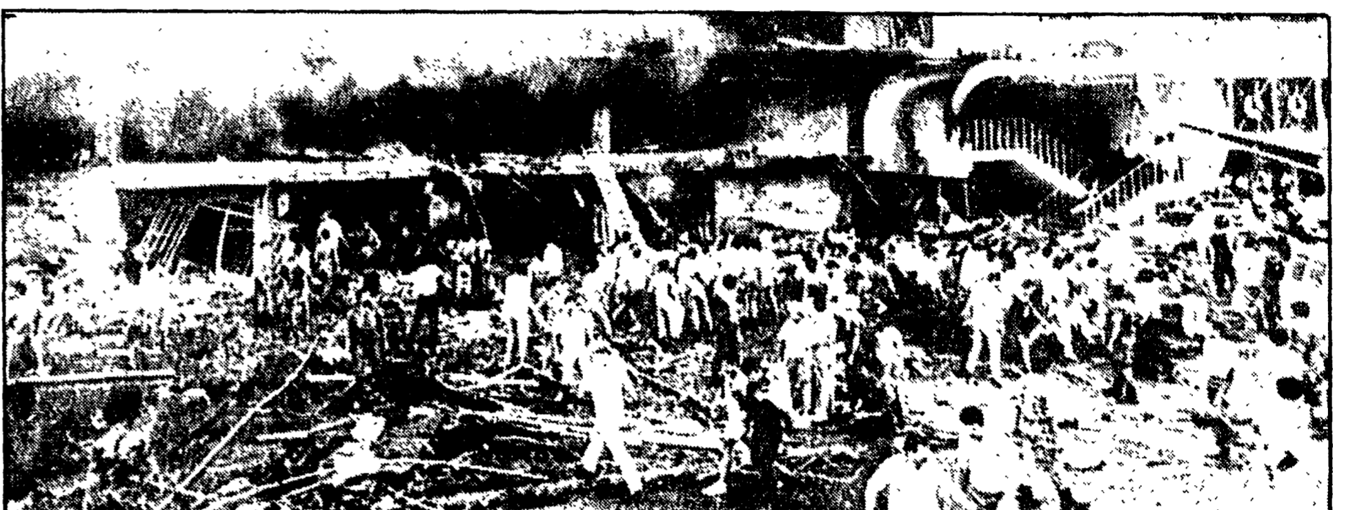
BEIRUT — Ambulanze, squadre di soccorritori e militari all'esterno dell'edificio completamente distrutto dall'esplosione dell'auto-bomba
