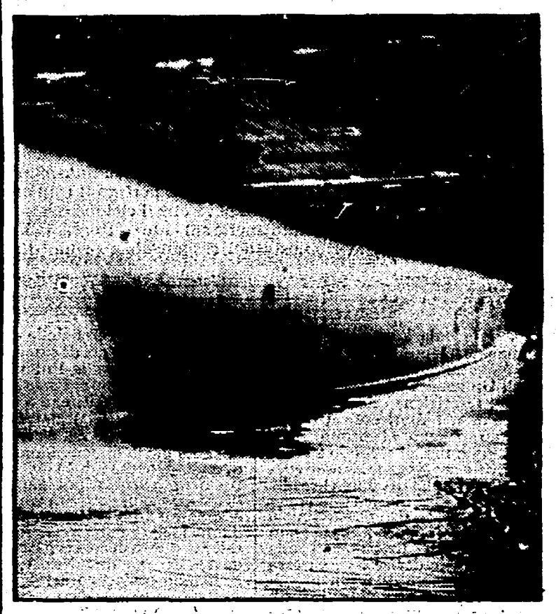
ROMA — Un'immagine dell'eccezionale allagamento nel sottoterra del Muro Torto provocato dalla rottura di una tubatura
