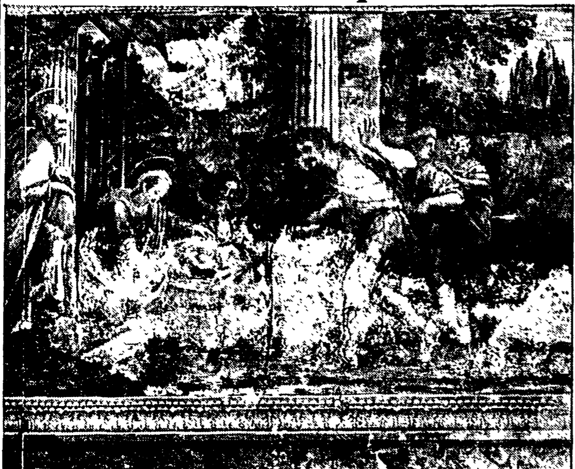
Segni di incuria a San Giovanni dei Fiorentini. In alto l'oratorio. Nel tondo la volta della cripta
