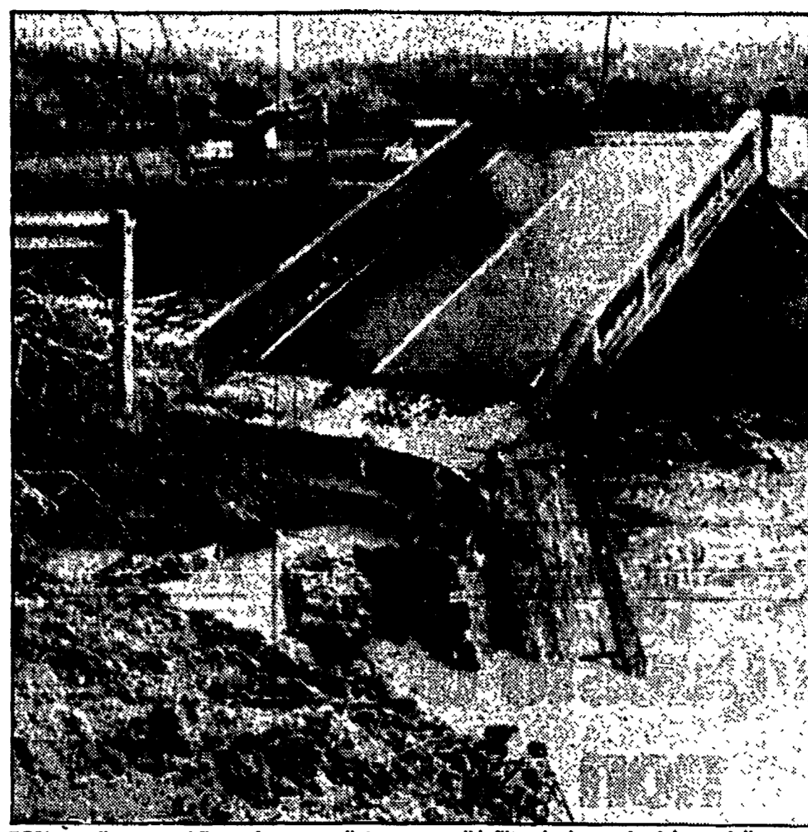
ROMA — Il ponte sul fiume Arnone crollato a causa di infiltrazioni e per la violenza delle acque
