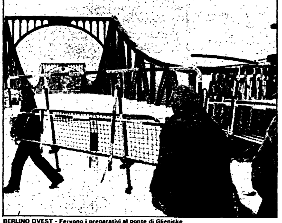
BERLINO OVEST - Fervono i preparativi al ponte di Glienicke
