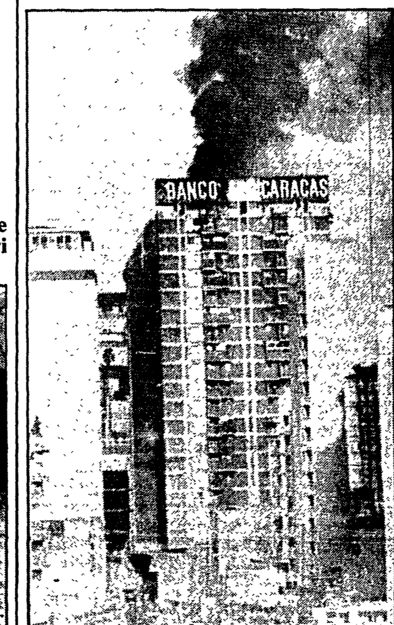
CARACAS — La Torre Cernica, sede dell'ambasciata cilena, devastata dall'incendio che ha causato quindici morti e feriti tra l'ambasciatore. Nel fondo, il salvataggio di uno scampato con l'uso dell'elicottero
