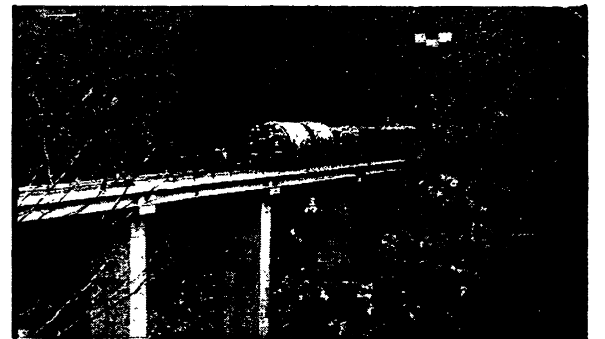
Passaggio della fresa sul ponte-canale nel «Rio Campagna»
