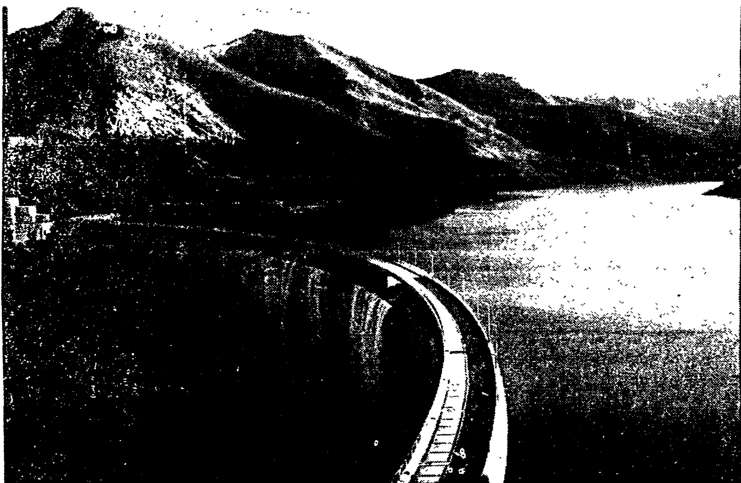
Panoramica della diga di «Ridracoli» con traccimazione dallo scarico di superficie
