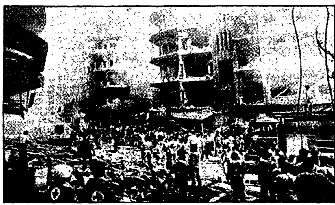
BEIRUT - Soccorritori tra le macerie dei palazzi distrutti dall'esplosione dell'auto-bomba
