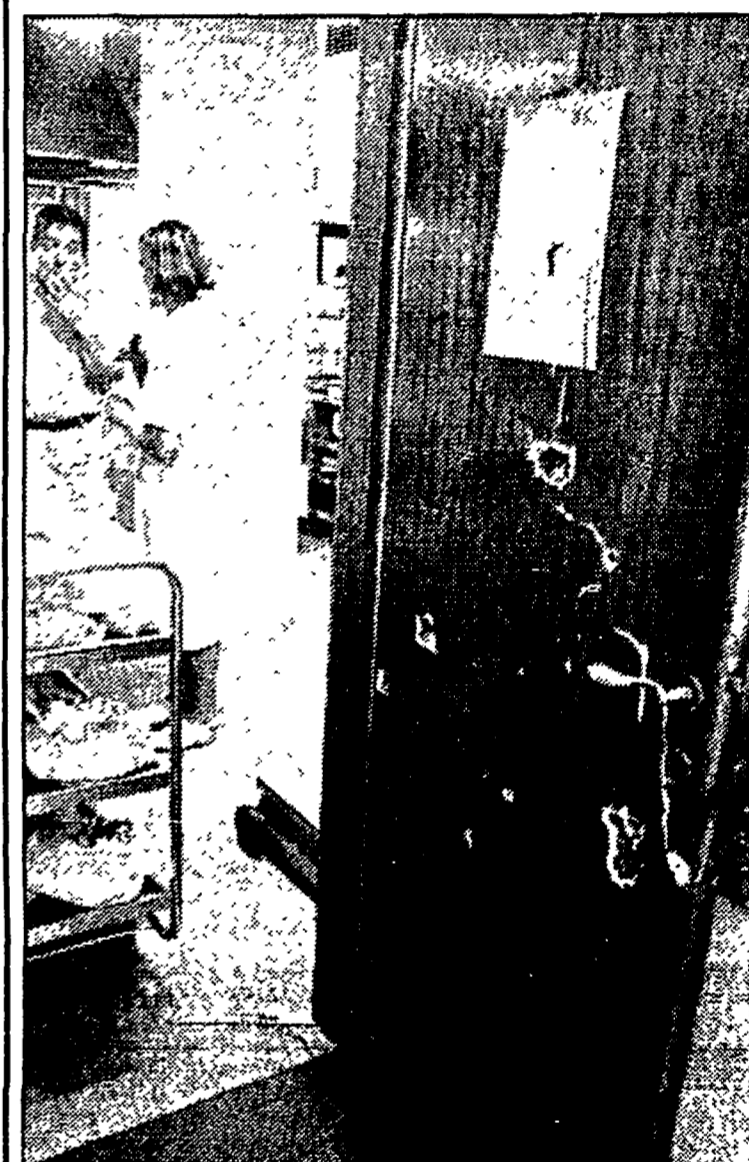
BOLOGNA - I danni sulla porta della stanza nella sede dell'Enea provocati dalle schegge della bomba ad orologeria
