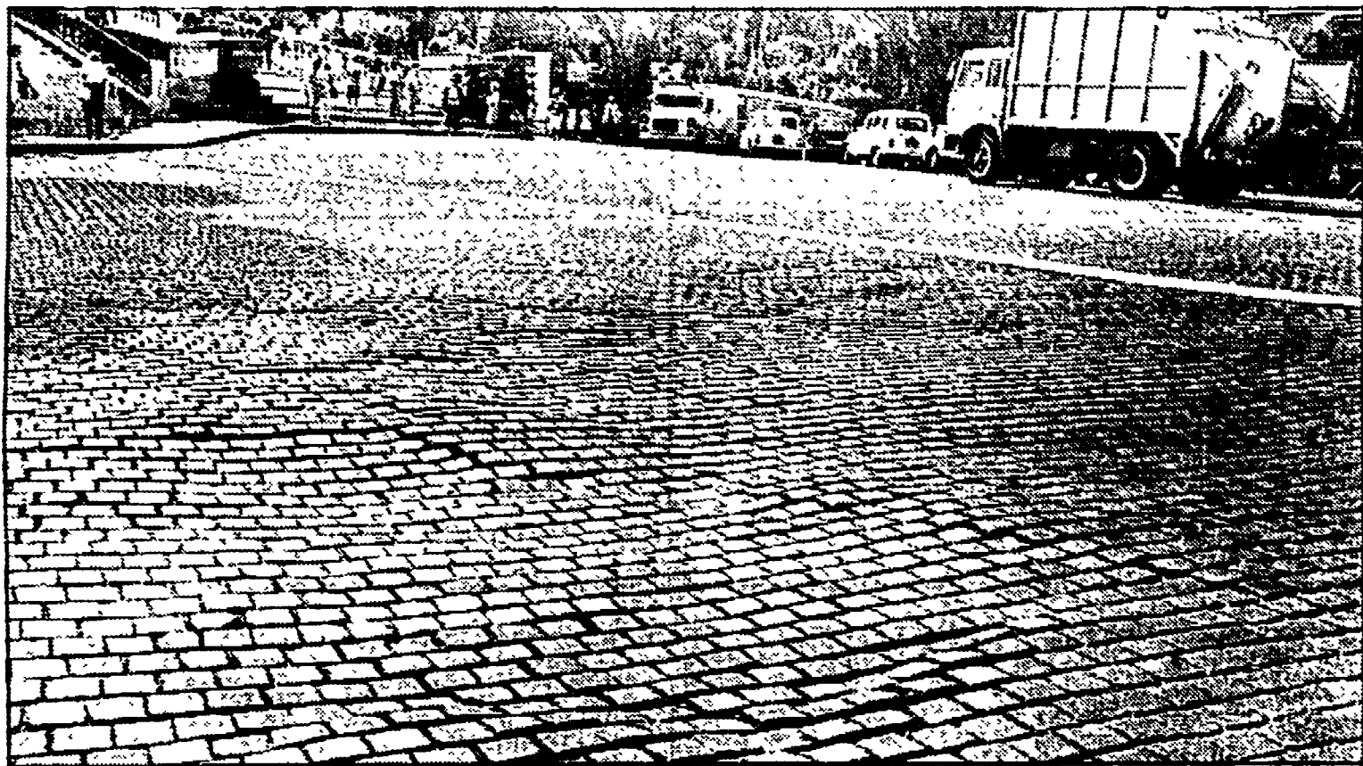
NELLE FOTO: I profondi avvallamenti creati sul fondo stradale di Piazza Venezia. «I rattoppi» consentiti dalla manutenzione ordinaria non bastano più ma per lavori straordinari ci vogliono troppi soldi, dicono in Circoscrizione. Così alla fermata dell'autobus si continua a «ballare».
