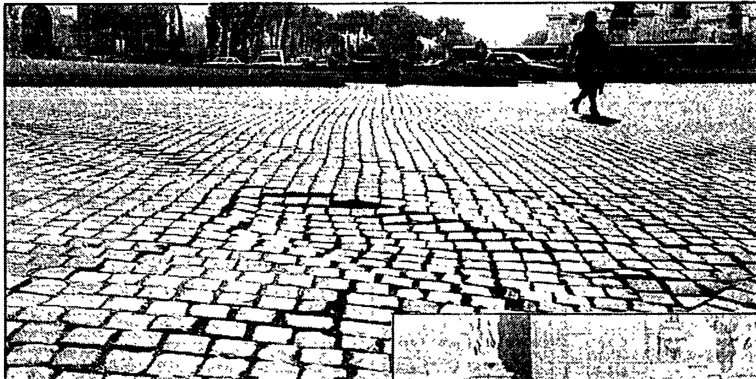
NELLE FOTO: I profondi avvallamenti creati sul fondo stradale di Piazza Venezia. «I rattoppi» consentiti dalla manutenzione ordinaria non bastano più ma per lavori straordinari ci vogliono troppi soldi, dicono in Circoscrizione. Così alla fermata dell'autobus si continua a «ballare».
