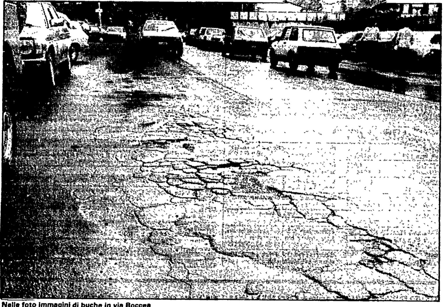
Nelle foto immagini di buche in via Boccea
