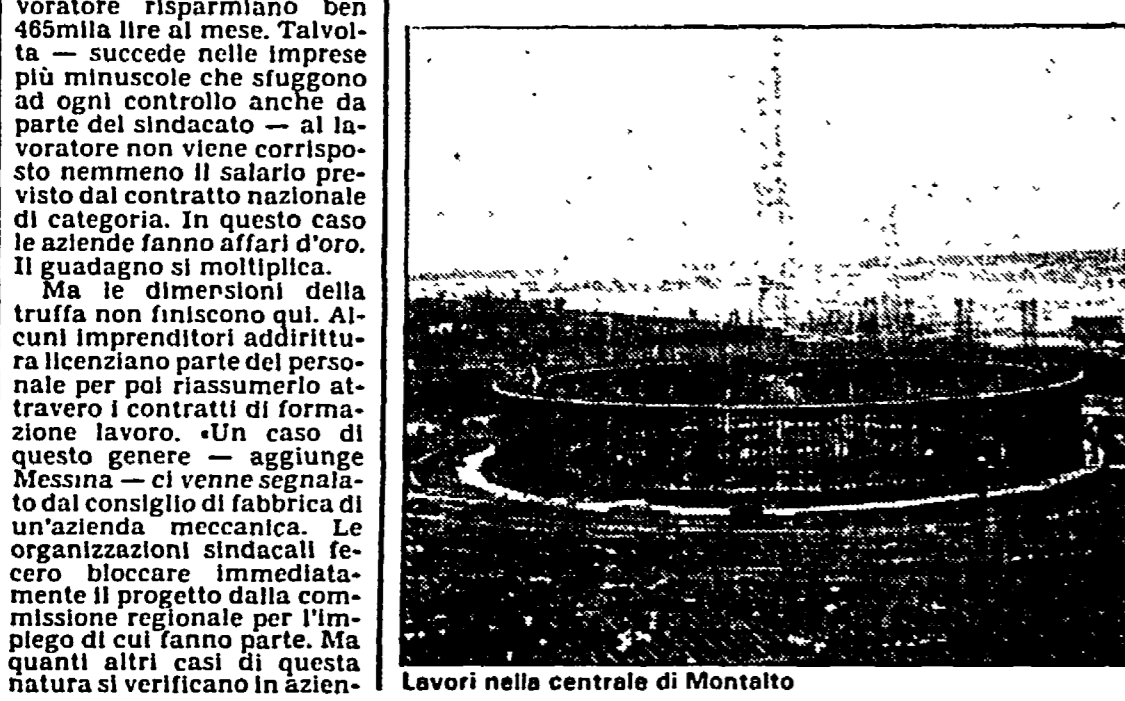
Lavori nella centrale di Montalto
