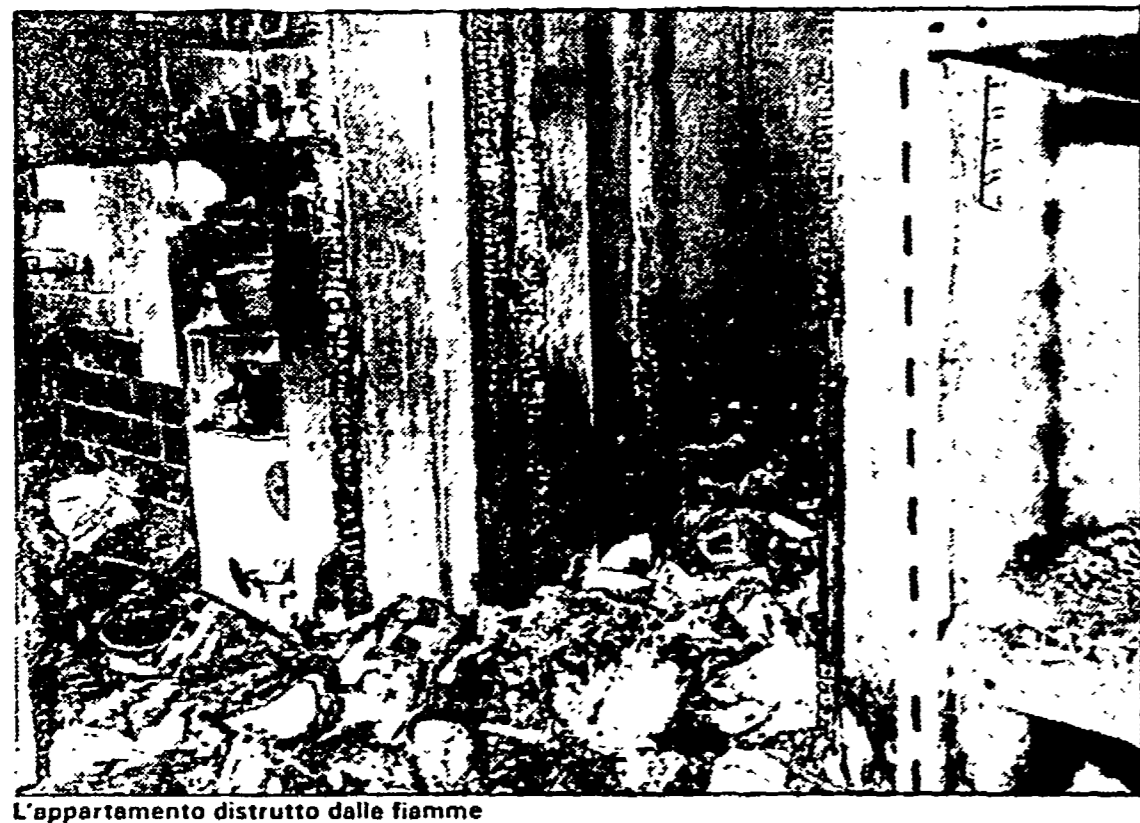
L'appartamento distrutto dalle fiamme
